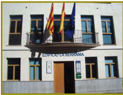
Fachada de la Sede de la Mancomunidad en Villar del Arzobispo.
